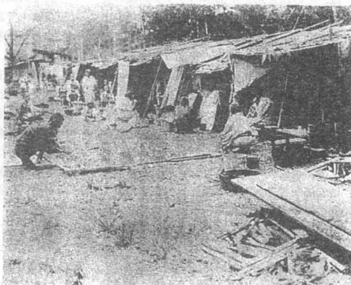
四谷十日市付近のバラック。
